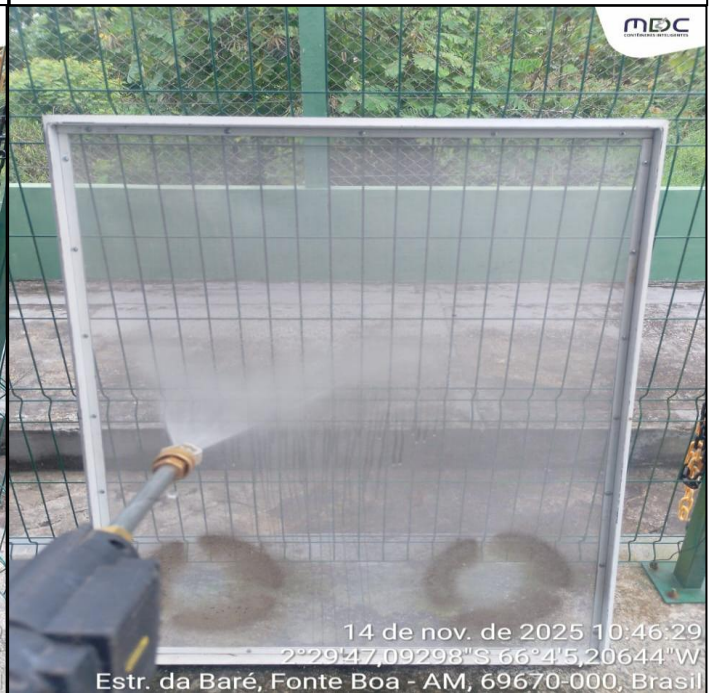
Filtros após o processo de limpeza , apresentando condições adequadas de operação.
