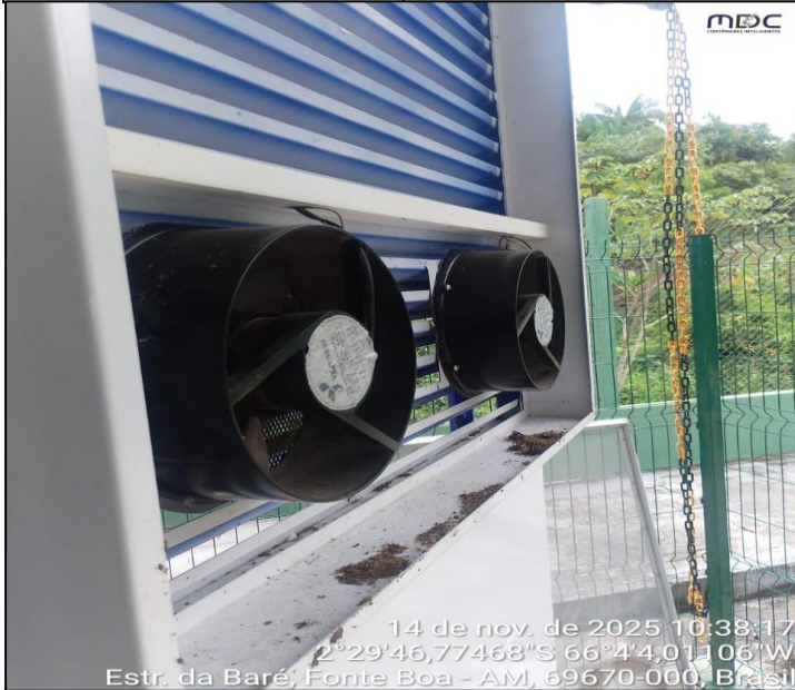
Ventiladores , apresentando condições adequadas de operação.
